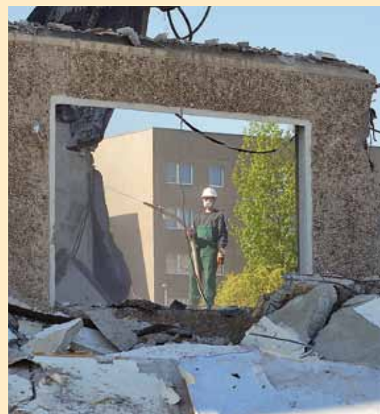
Durch den Abriss von Gebäuden in Bernburg Süd-West konnte die Leerstandsquote halbiert werden.
