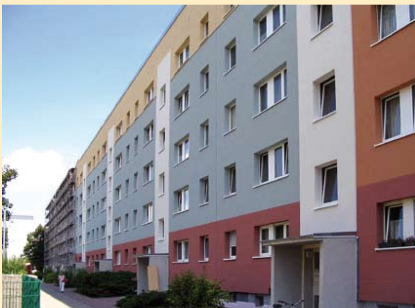
Nicht nur äußerlich erhielt der Wohnblock Vor dem Nienburger Tor 4-12 in diesem Jahr eine komplexe Modernisierung.
