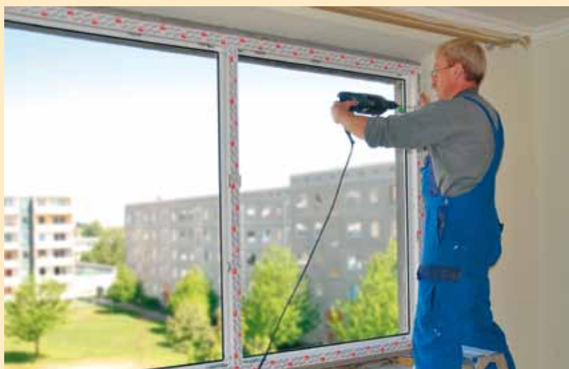
Fenstermodernisierung im Albert-Schweitzer-Ring
